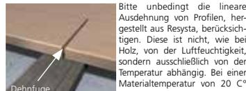
sind je 1m Bodendiele 1,5 mm Abstand für die lineare Ausdehnung zu berücksichtigen. Die Ausdehnung bei abweichenden Materialtemperaturen entnehmen Sie bitte dem Diagramm.
